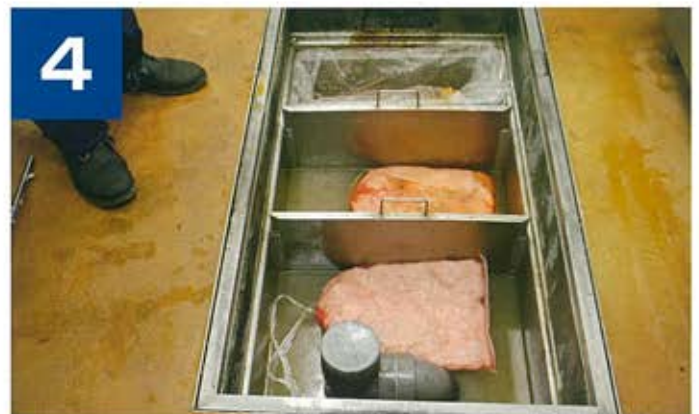
4 新しいオイルホールドを浮かべて終了です。
