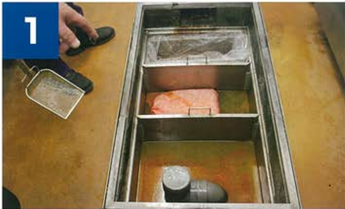
1 グリストラップの油槽に浮かべてください。 水は吸わないので沈みません。
